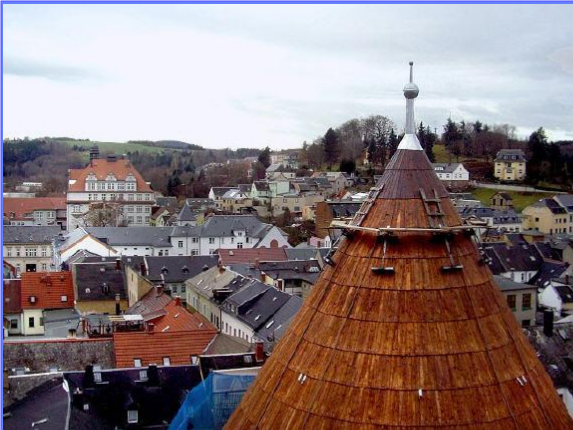
Krönung der Dachdeckerarbeiten: die Turmhaube sitzt auf dem Dach!
